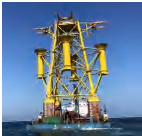
图 3.5-5b 多筒导管架示意图
