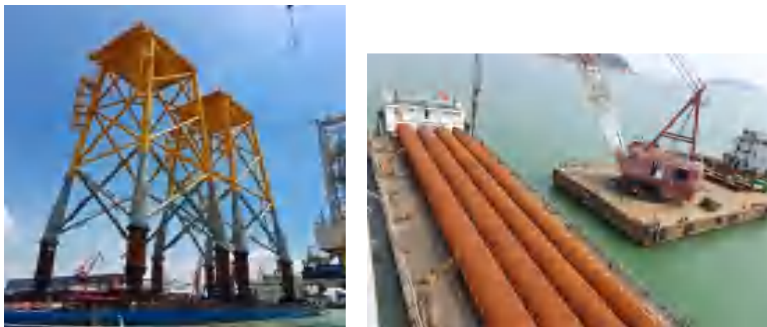
图 3.5-3 导管架、钢管桩运输示意图
