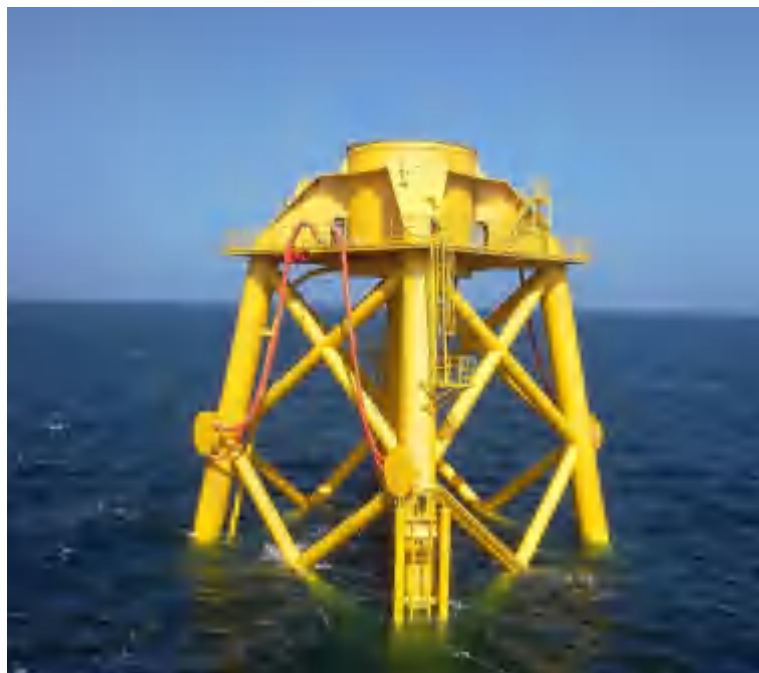
图 3.5-7 四桩导管架基础结构示意图
