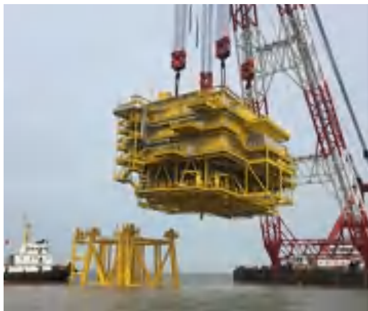
图 3.5-13 上部平台整体吊装示意图
